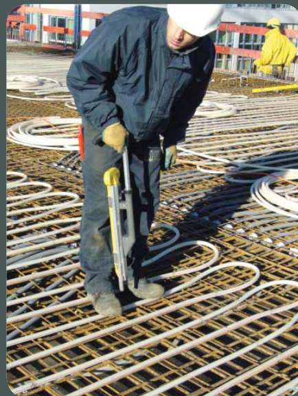
Termostatowanie rdzenia betonowego
